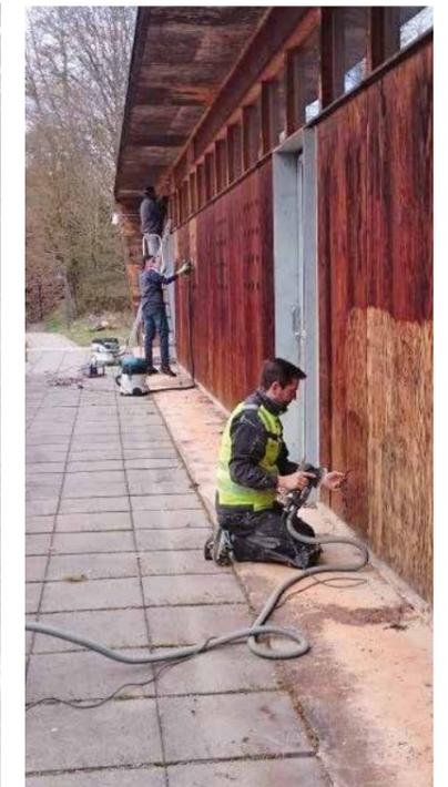
Im Juni wird Firma Dörflinger die schwarz und undicht gewordene Lichtelemente-Fassade im Bereich des Hallenvorbaues erneuern.
